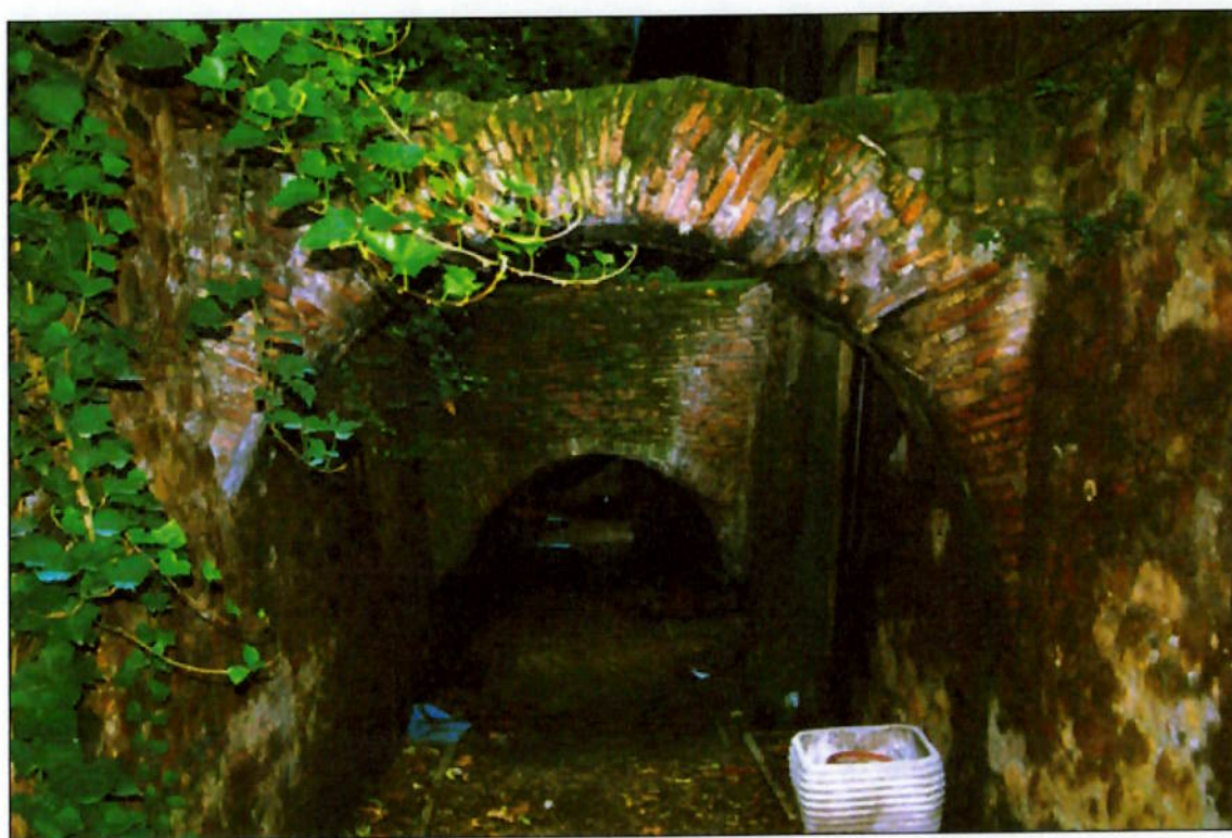
Figura 6 - Vista interna da Cloaca Máxima de Roma desativada (Hopkins, 2008)
