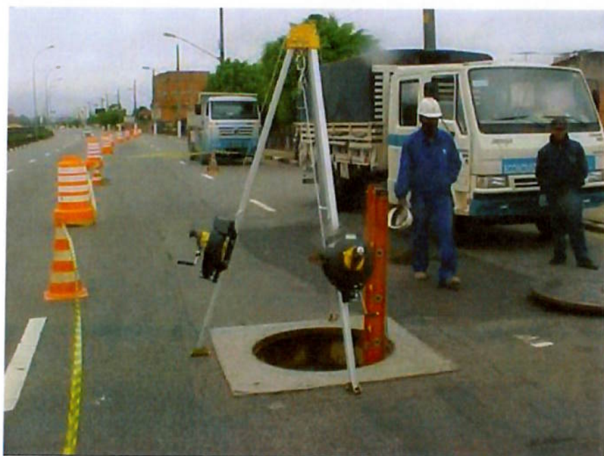
Foto 9 - Preparação para entrada no PV
