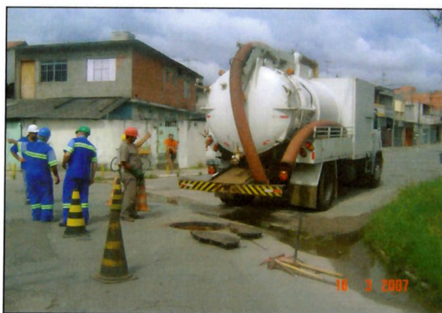
Foto 5 - Isolamento de área para desobstrução PV
