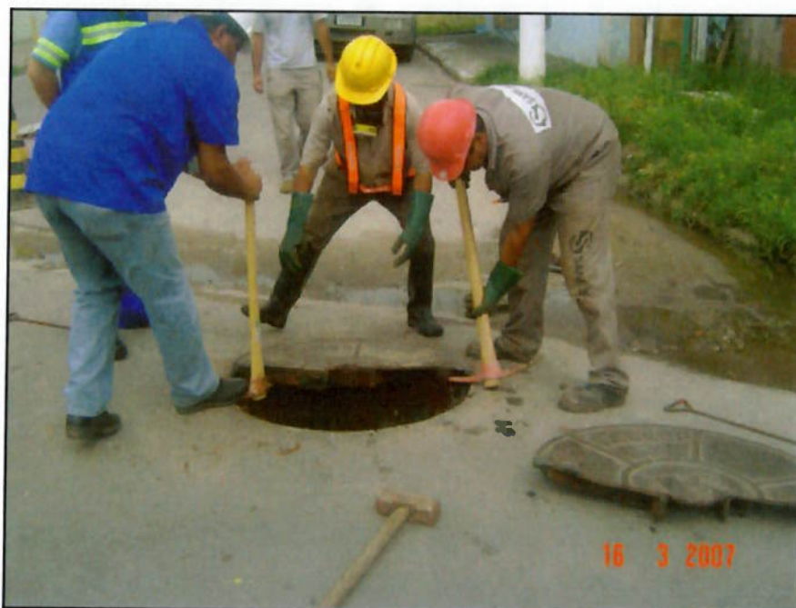
Foto 7 - Abertura do PV com uso de picareta e marreta
